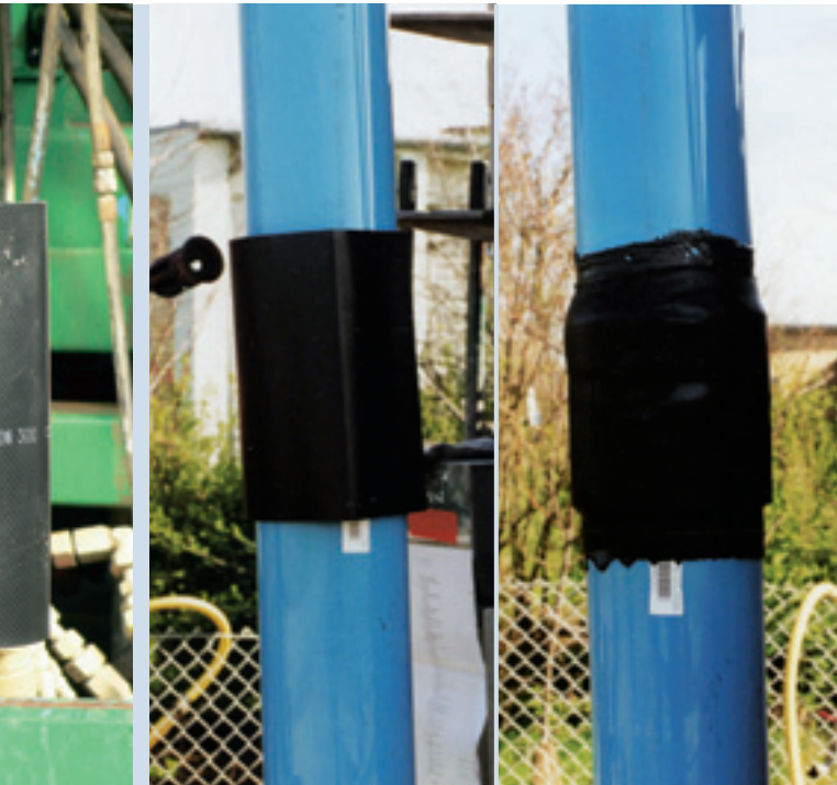
◁ Abb. 4 a + b Schrumpfmuffe während und nach der Erwärmung
