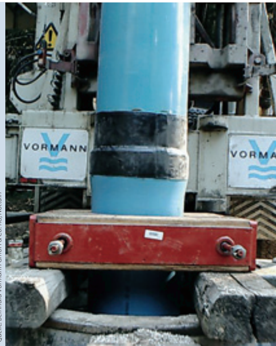
▷ Abb. 5 Fertig aufgebrachte Schrumpfmuffe
